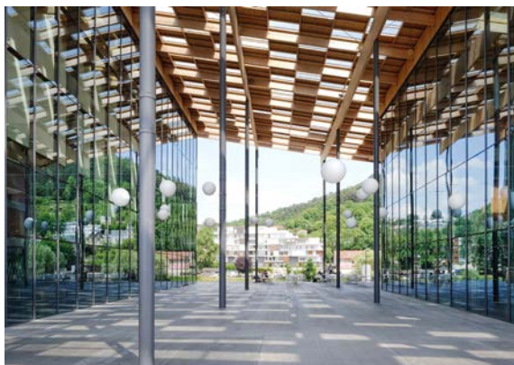
Frac Franche-Comté, Cité des arts, Besançon © Kengo Kuma & Associates / Archidev ; crédit photo : Blaise Adilon
